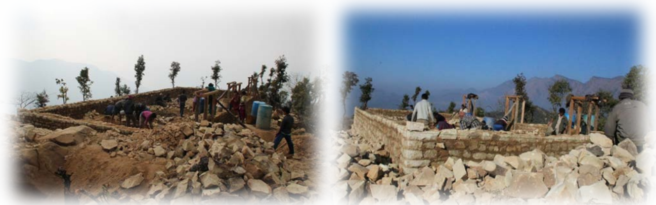
전기시설 설치 후 마을의 수익 증대를 위해 건축하고 있는 LED 양계장 건물의 공사 사진 (2012.1.21)
