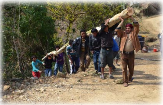
69개의 나무 전신주 만들기 및 배선 공사
