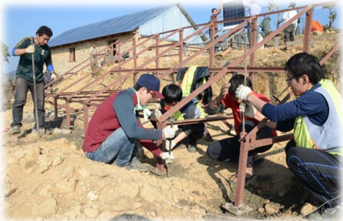
태양광 패널을 설치하기 위한 철골 프레임 공사
